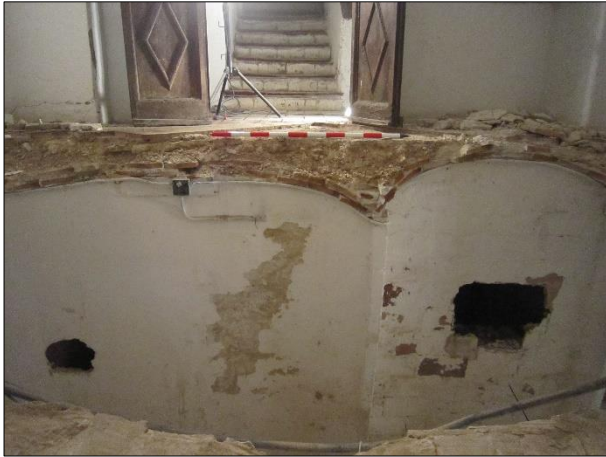
FOTO 25. Vista en secció de l'interior del forjat de l'altell, amb les voltes de maó a la part inferior i el paviment a la mescla a la part superior.
