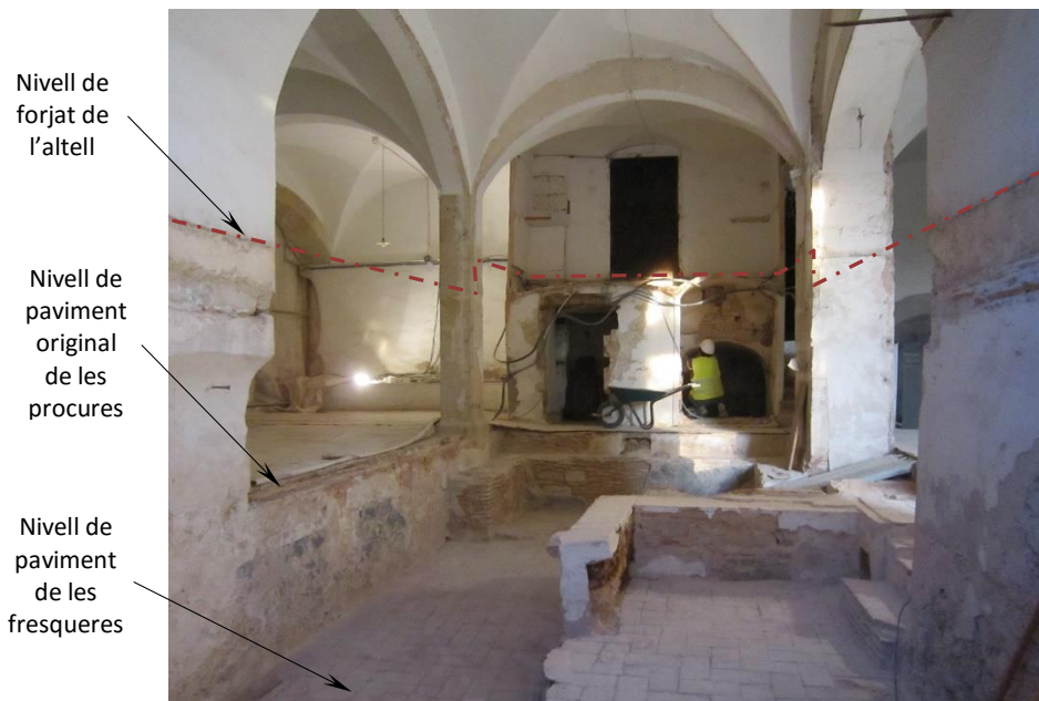
Figura 2: Estat de la crugia un cop desmuntats els forjats i els envans.
