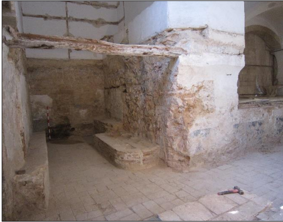
FOTO 33. Vista del buidat del rebliment de la volta ubicada a la crugia més meridional.
