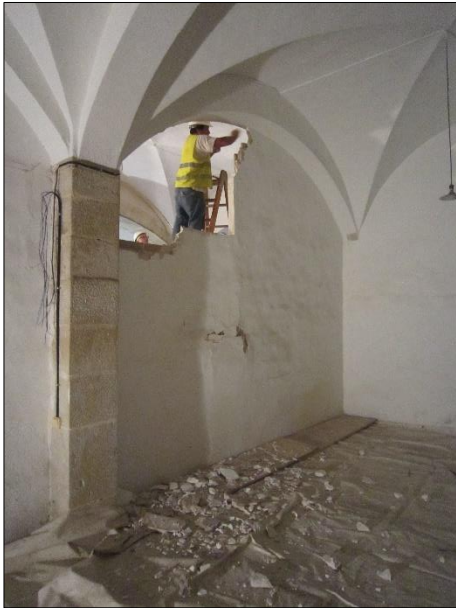
FOTO 21. Treball d'enderroc manual de l'envà lateral oest de l'altell.
