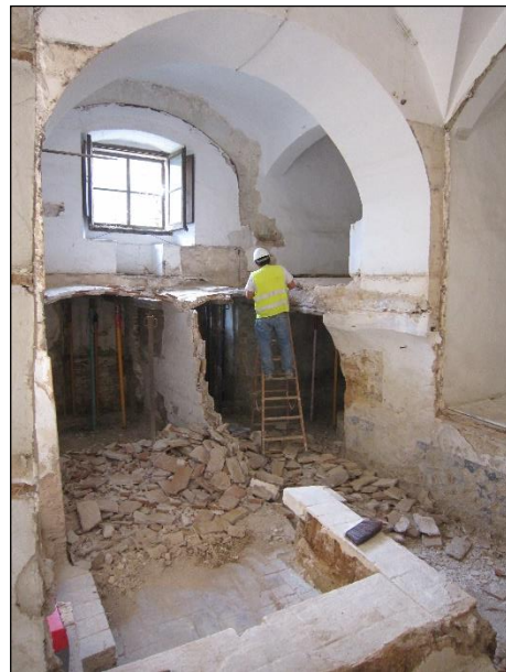
FOTO 24. Procés d'enderroc del forjat de l'altell.
