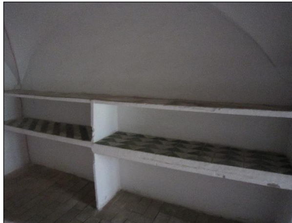
FOTO 16. Detall de les prestateries d'obra enrajolades que tenia la "sala del pa".
