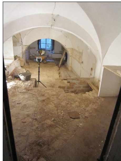
FOTO 20. Vista de l'interior de l'altell durant la retirada del paviment de rajoles.
