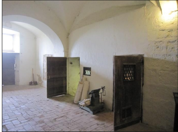
FOTO 2. Vista general de la part central de les procures. El cegat dels arcs que s'observa correspon a l'altell a enderrocar.
