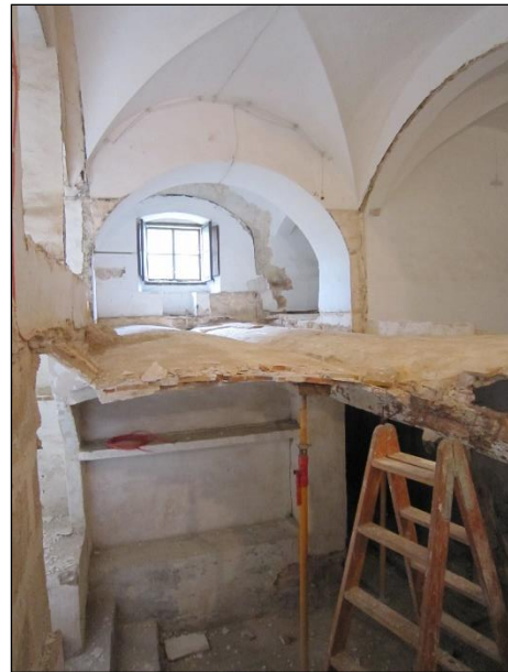
FOTO 28. Vista en secció de les voltes de maó de l'altell formades per una doble filada de maó.
