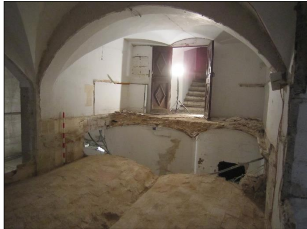
FOTO 22. Forjat del rebedor de l'altell un cop eliminat, deixant a la vista el passadís que comunica els espais de les procures.
