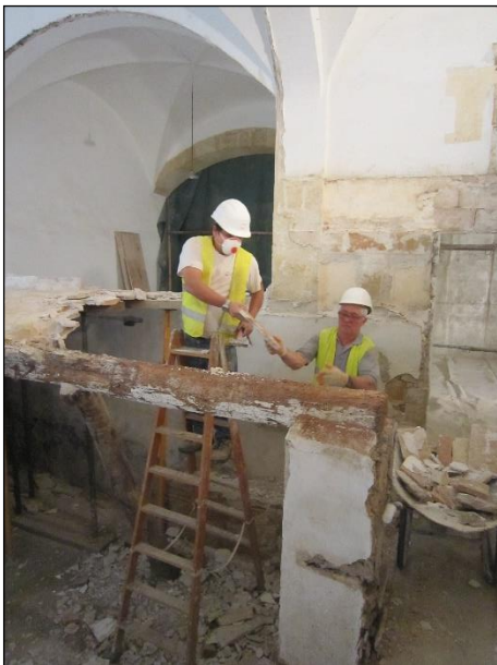
FOTO 23. Procés d'enderroc del forjat de l'altell anomenada "Sala del pa".
