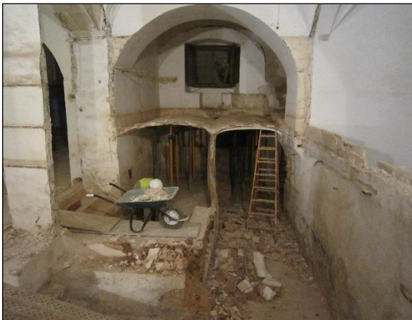
FOTO 19. Vista del procés de desmuntatge de les estructures de l'altell.
