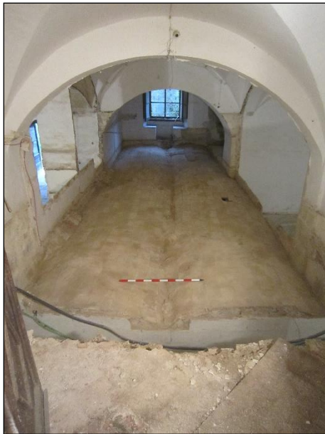
FOTO 27. Vista de les voltes de maó que sustenten l'altell un cop retirat el paviment a la mescla i la runa que farceix el seu interior.
