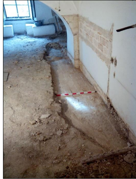
FOTO 26. Vista del procés de retirada de runa que omple l'espai de les voltes.
