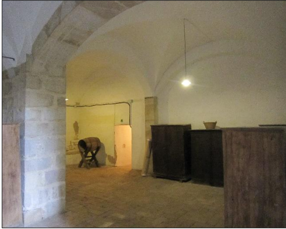
FOTO 1. Vista general de la part oest de les procures. Al fons el cegat dels arcs correspon a l'altell a enderrocar.
