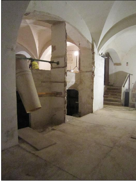
FOTO 17. Vista general de l'altell durant el procés d'enderroc dins les procures de l'edifici de la infermeria.
